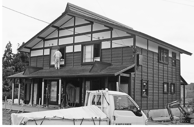
山古志の若い人むけ復興公営住宅。住宅内は仕切りで二戸に分けられ、退去後も住民の活動やグループホームなどにも転用可能。地元木材で被災者の大工が建てた。(岡田知弘さん提供)
