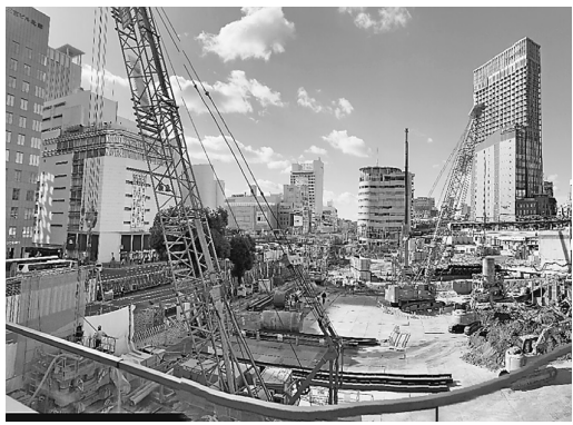
神戸市三宮駅前の再開発の現場
