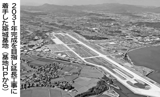
2031年完成を目指し延長工事に着手した築城基地(基地HPから)
