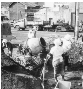
道路舗装工事の作業をする久世さん(後ろ姿)
